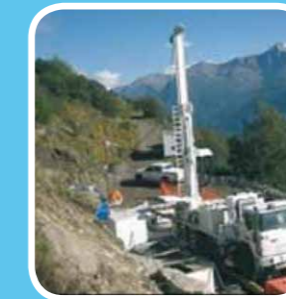
Sondaggio in roccia
